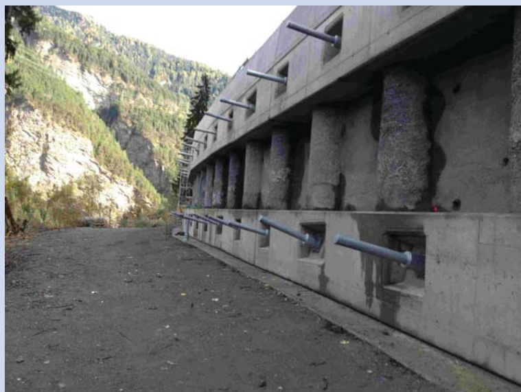
Bohrwandpfahlwand mit Litzenüberstand
