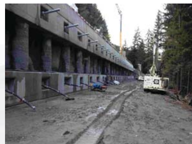
Bohrpfahlwand talseitig
