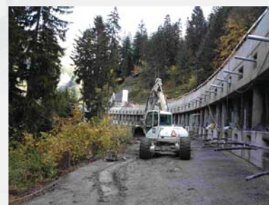
Bohrpfahlwand talseitig
