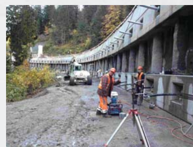
Bohrpfahlwand talseitig
