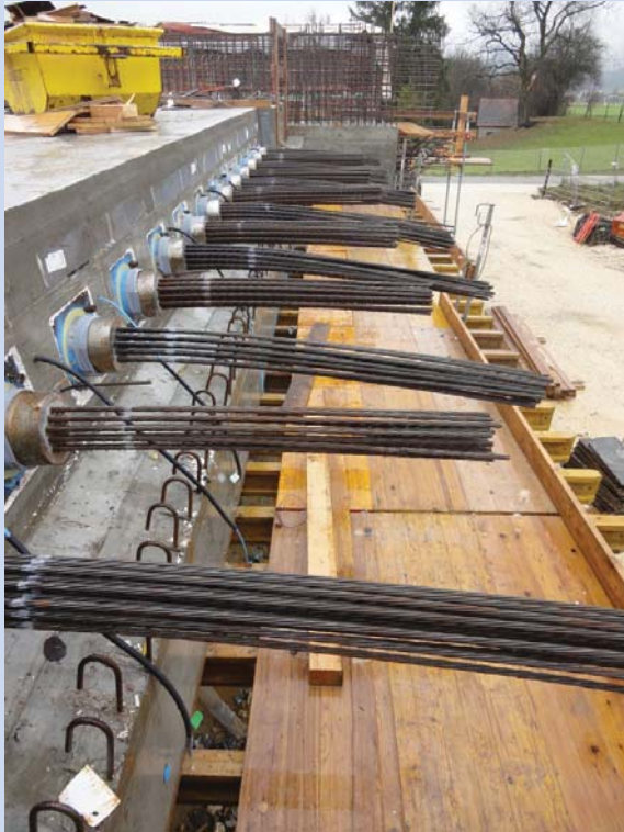
Ostende der Süd Brücke - 100% vorgespannt
