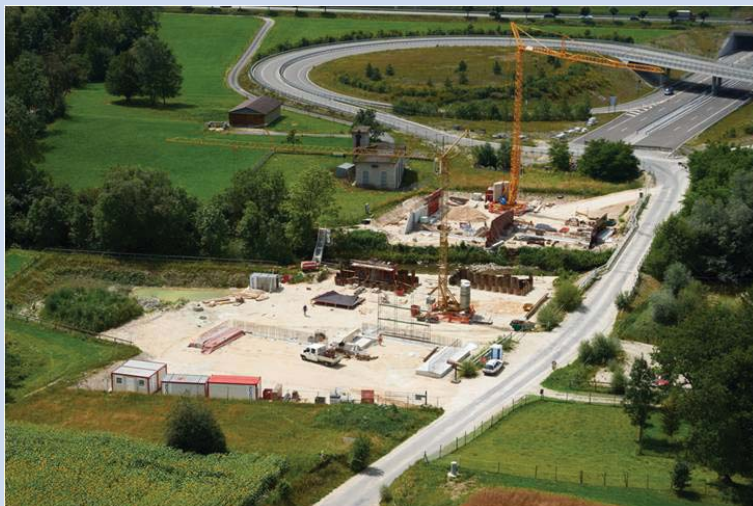
Flugansicht der Baustelle
