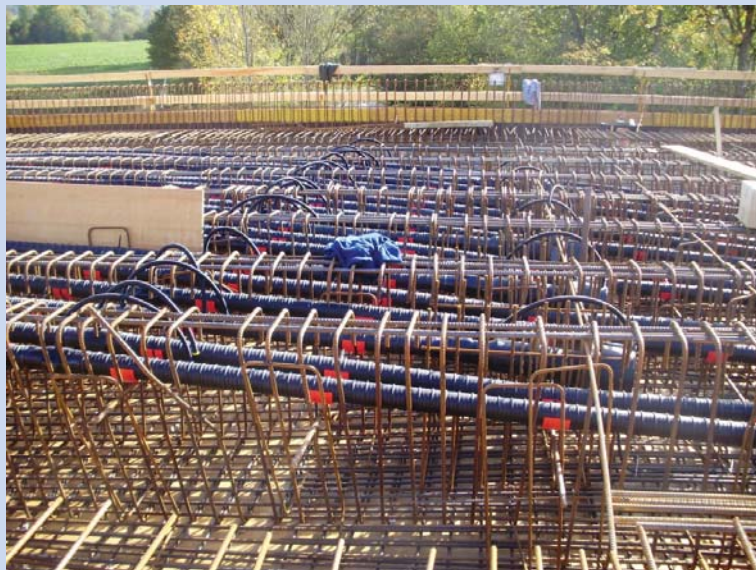
Fester Kopf Kategorie C (Werkfertigung) und leere Hüllrohre (Baustellenfertigung) für die Kabel welche die Brücke durchqueren.
