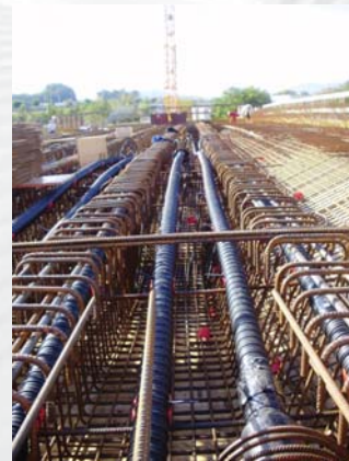
Queransicht der Vorspannung auf dem mittleren Stützpunkt
