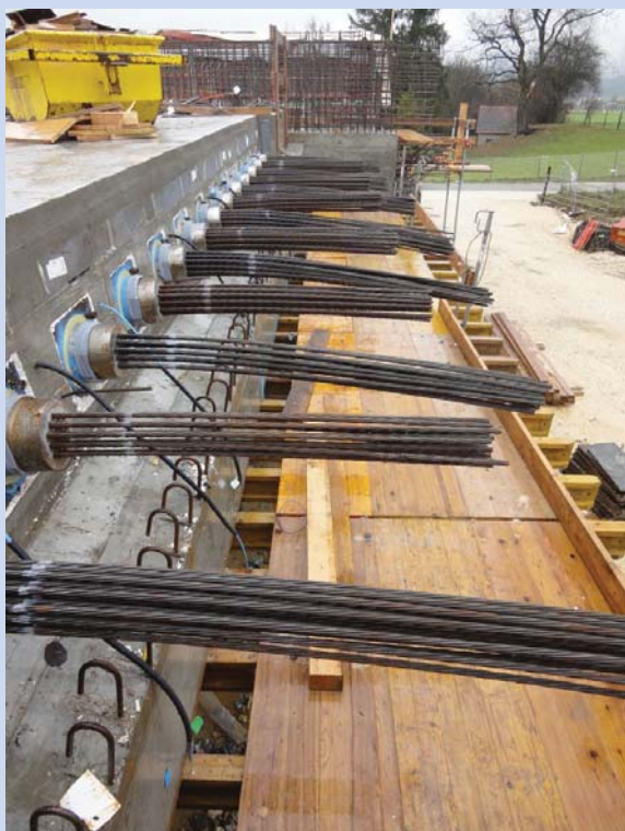
Extrémité Est du Pont Sud - Mise en tension effectuée à 100%
