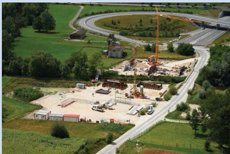
Vue aérienne du chantier
