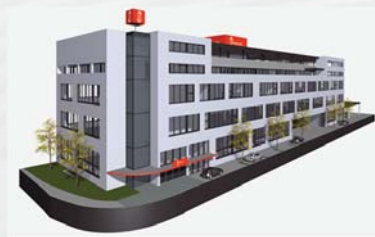
Neues Hauptgebäude Henseler AG Bildquelle: henseler.ch
