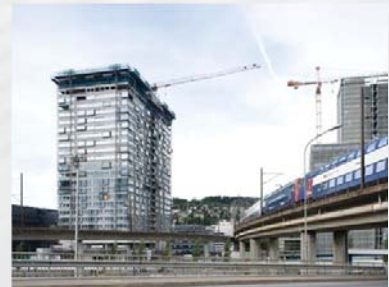
Gesamtansicht der Baustelle
