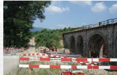
Alte Brücke vor dem Abbruch
