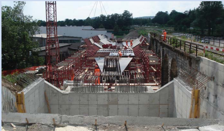
Brücke „Ponte sul Laveggio“ im Bau, rechts die alte Brücke
