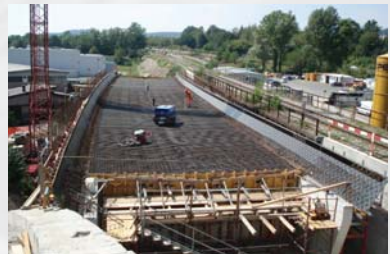
Brücke „Ponte sul Laveggio“ kurz vor dem Betonieren
