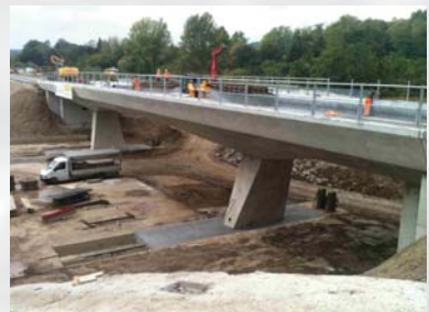
Fertig erstellte Brücke nach dem Verschub und Abbruch der alten Brücke
