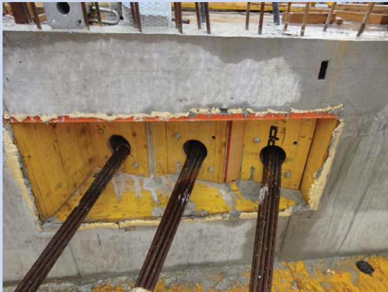
Schalung der drei Nischen für die Vorspannkabel CONA 12-06
