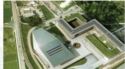
Ansicht vom fertiggestellten Projekt
