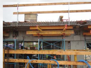
Câble mis en tension
