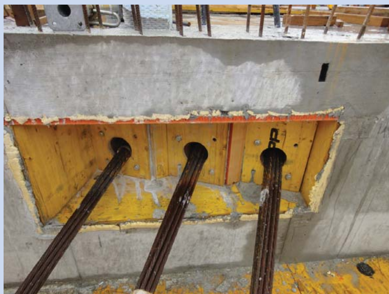
Coffrage de trois niches pour câbles de précontrainte CONA 12-06
