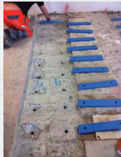
Druckverteillaschen
