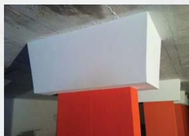
Durchstanzverstärkung
