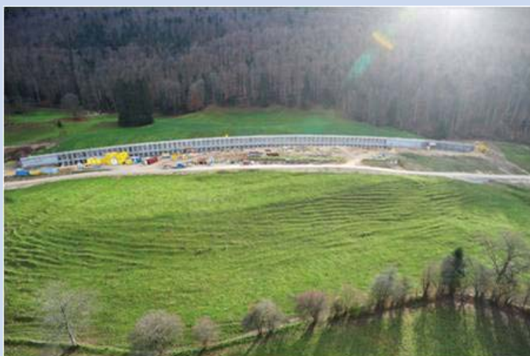
Gesamtansicht der Hangsicherung
