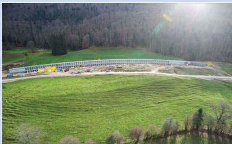
Vue d'ensemble du mur
