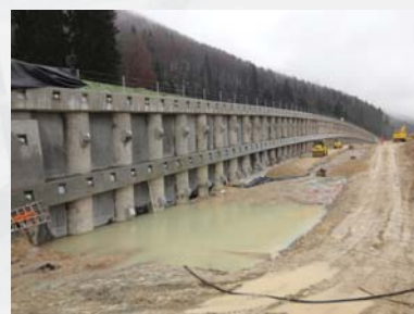
Mur de soutènement
