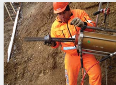
Prüfen und festsetzen der Anker mit CFK Presse
