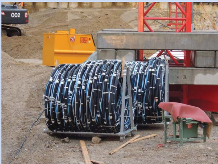
Beginn der Baustelle mit der Ankeranlieferung
