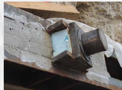
Ankerkopf mit Keile
