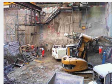
Enge Platzverhältnisse - sei es bei den Prüfungen oder beim Ausbau der Anker
