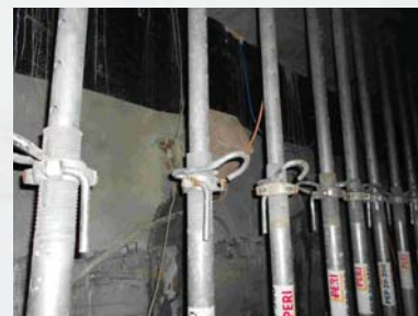
Enge Platzverhältnisse - in einem Zwischengeschoss für den Ausbau
