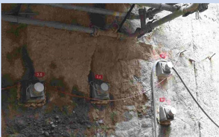
Anker L6 - speziell abgedichtet da die ganze Baustelle im Grundwasser steht
