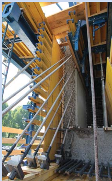
Stegvorspannung Dywidag GS \varnothing 32 mm
