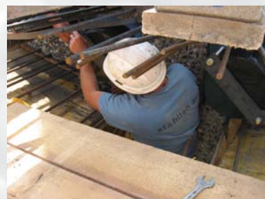
Montage der Schutzhauben
