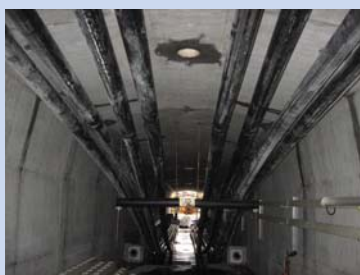
Kontinuitätsvorspannung im Hohlkasten
