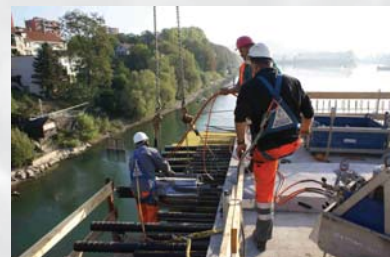
Spannarbeiten beim Freivorbau
