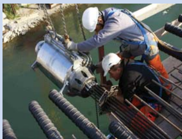
Einfädeln der Spannresse
