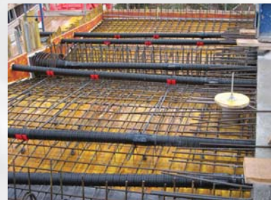
Kragarm Vorspannung
