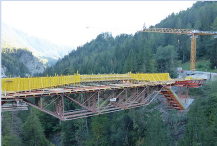
Versamertobelbrücke erste Betonierphase
