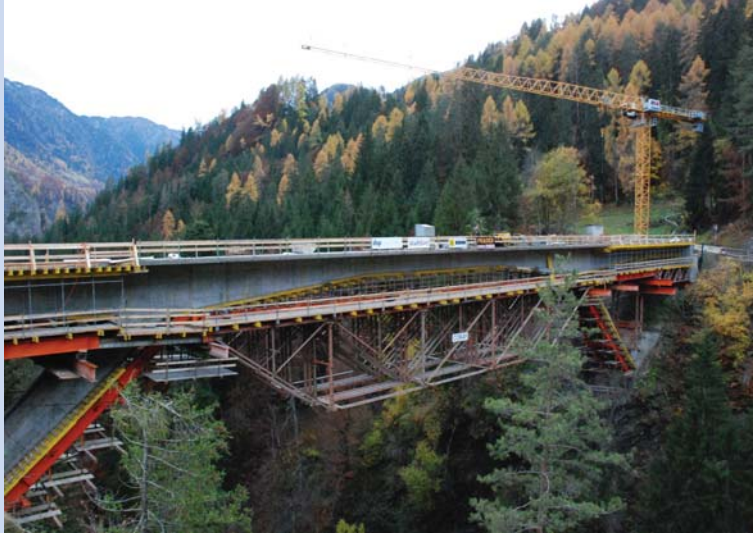
Versamertobelbrücke zweite Betonierphase
