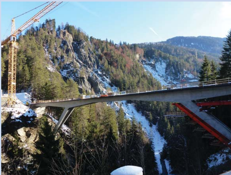
Versamertobelbrücke dritte Betonierphase
