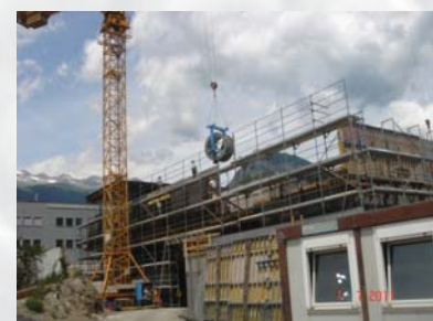
Montage Vorspannkabel mit Kran
