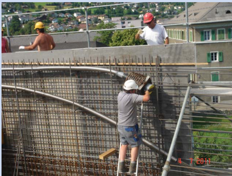
Montage fester Ankerkopf an der Westwand
