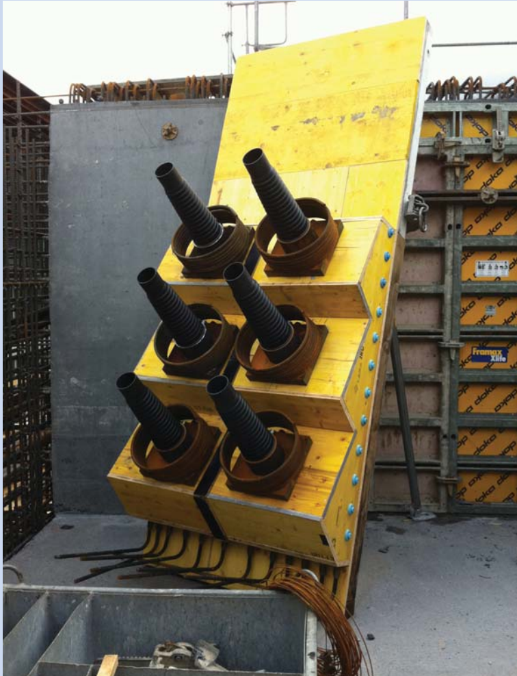
Vorfabrizierte Ankerkopfschallungen
