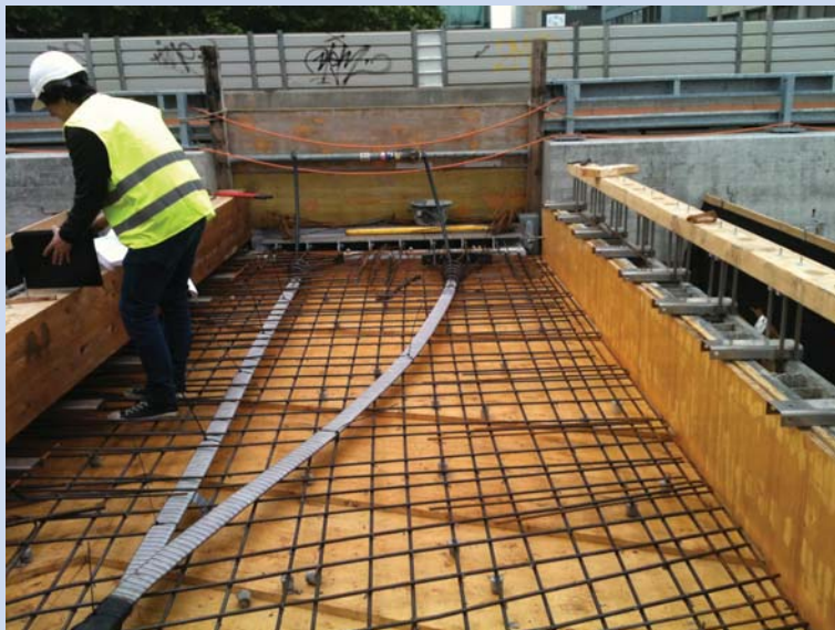
Einbau in die Passerelle
