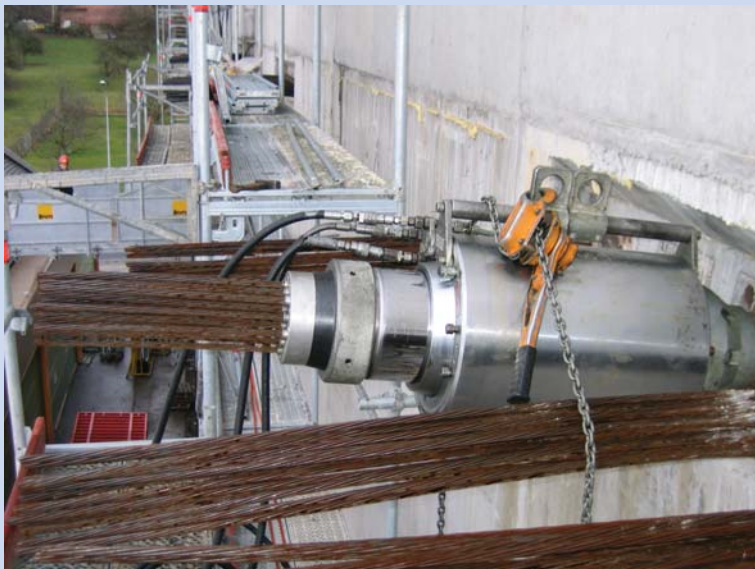
Spannen der Kabel
