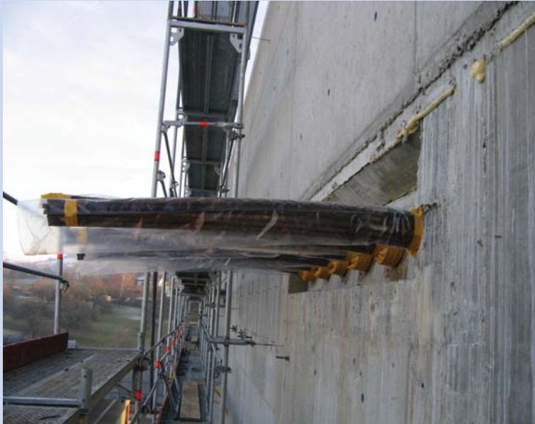
Der Plastik ist zum Schutz vor Korrosion angebracht worden.
