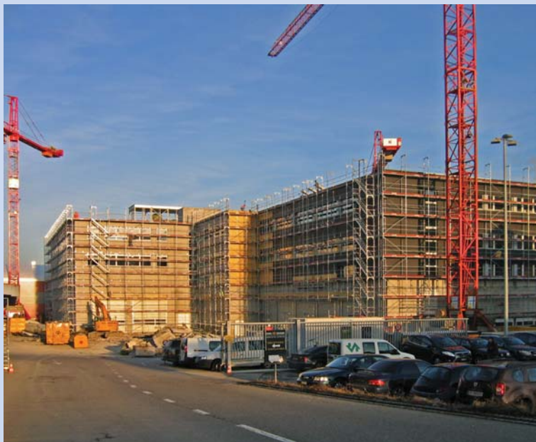
Neubau mit Werkstatt und Lagerhalle
