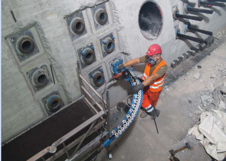
Einstossen der PE-Ummantelten Litzen
