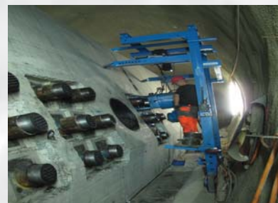
Hebegerät für die Vorspannarbeiten
