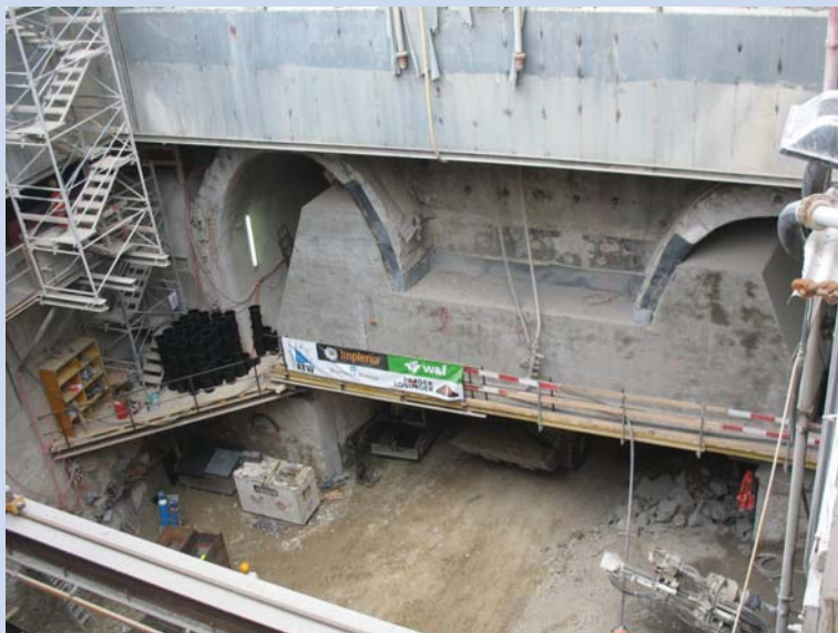
Querschnitt der Baustelle mit Abfangdecke
