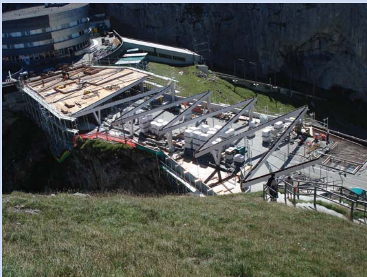
Panoramagalerie im Bau
