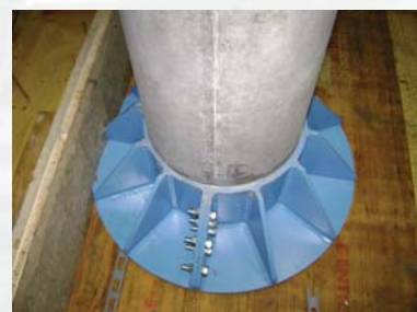
Tête de poinçonnement posée avant ferrailage
