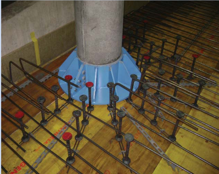
Tête de poinçonnement avec renforts Ancotech
