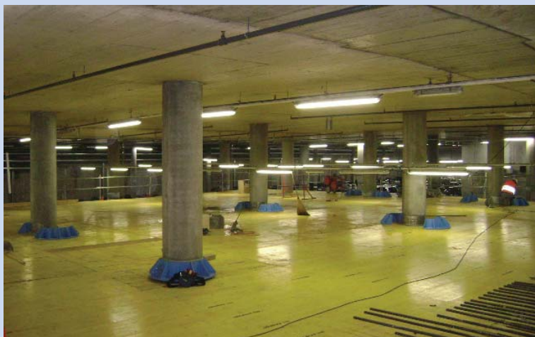
Sous-sol supplémentaire coffré
