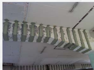
fertige Schubverstärkung
