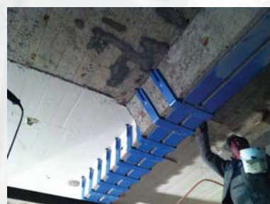
Schubbügel Montage
