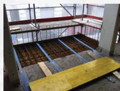
Lamellen-Zugbänder für neu angehängte Balkone
