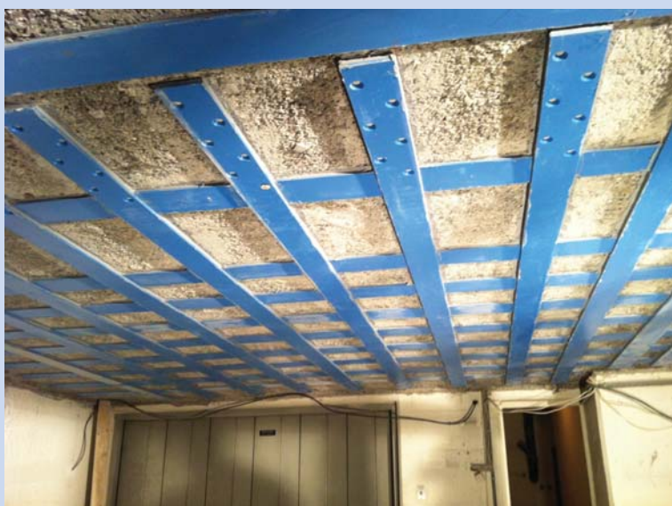
Stahllamellenverstärkung im UG
