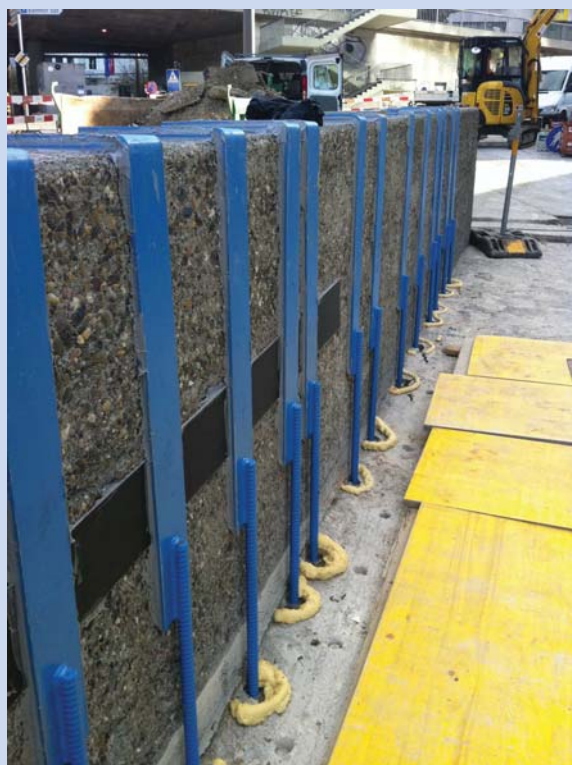
Seitlich aufgeklebte CFK-Lamellen und Stahl-Schubbügel
