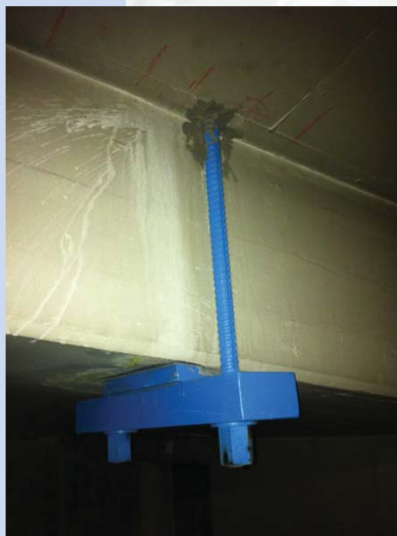
Verankerung mit Querlaschen u. Druckverteiplatten
