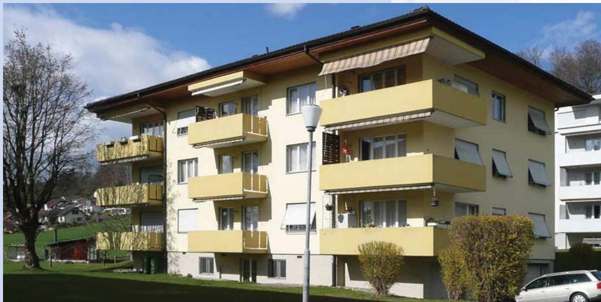
Totalsanierung MFH Herrenacker, Uznach
