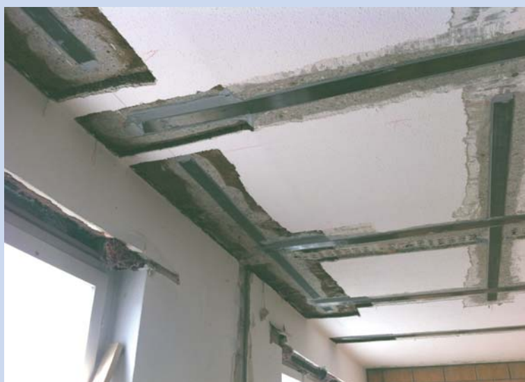
Verklebte CFK-Lamellen
