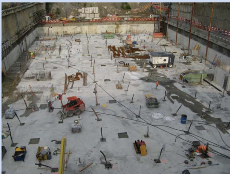
Baugrube mit permanenten Ankern
