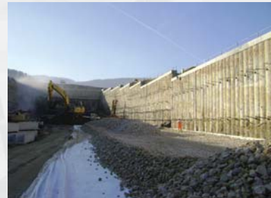
Pieux en béton
