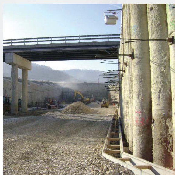
Vue générale à l'entrée de l'enceinte de fouille
