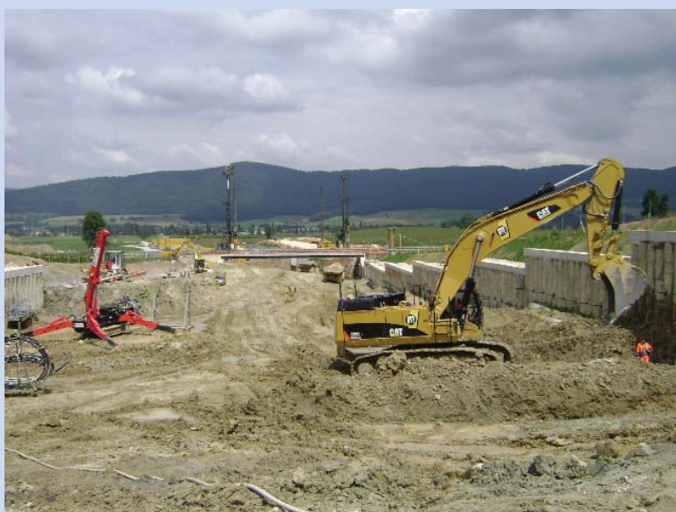
Vue générale depuis le portail du tunnel
