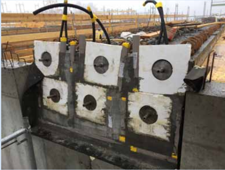
Vorgespannter Träger mit 6 Vorspannkabeln
