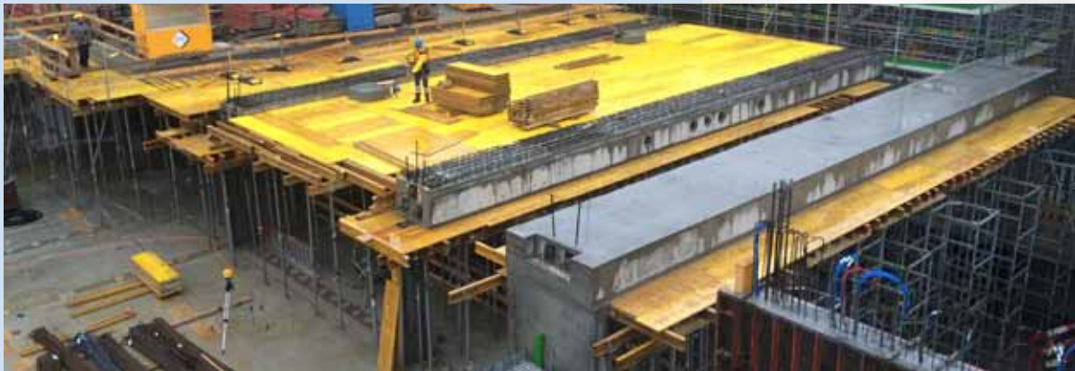
Vorgespannte Träger für Decke UG
