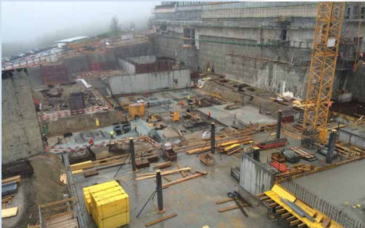
Übersicht Baustelle UG und EG
