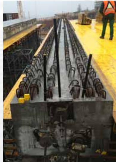
Vorgespannte Träger mit System BBRV
