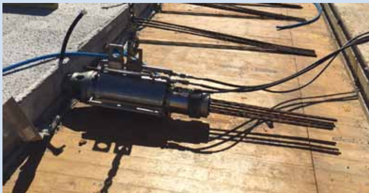
Spannen der Kabel in der Decke
