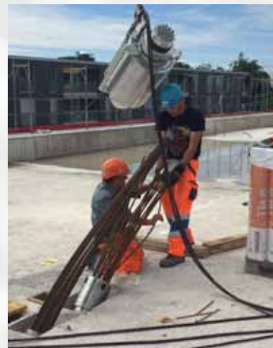
Spannen der Kabel in der Wand
