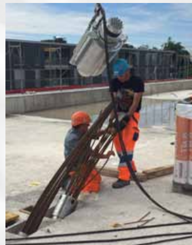
Mise en tension câbles des murs
