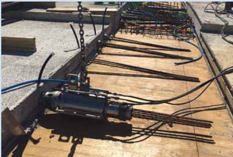
Mise en tension câbles longitudinaux
