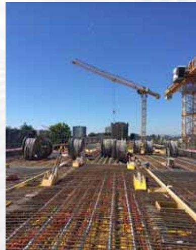
Pose des câbles
