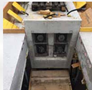
Träger mit Vorspannung System BBRV
