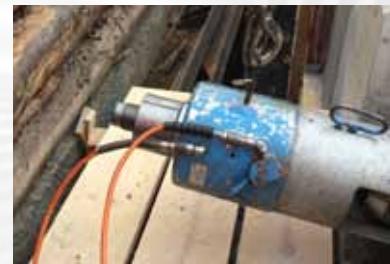
Spannarbeiten mit Drahtvorspannung BBRV
