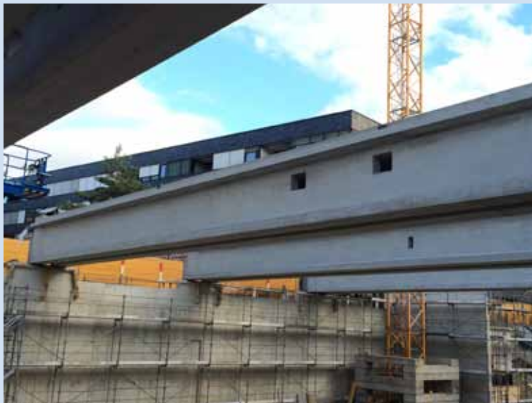
Einbau der vorgefertigten Träger
