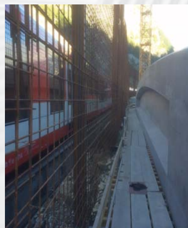
Alte Brücke mit Bahnverkehr, neue in Bau
