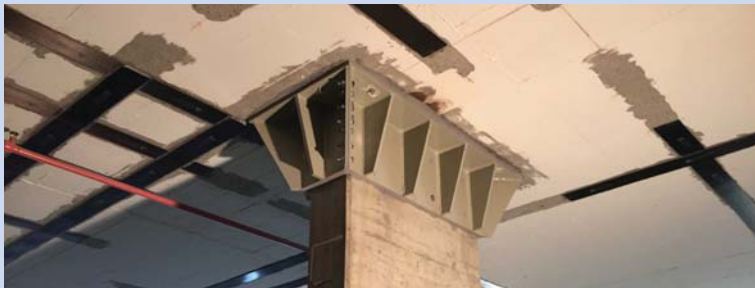
Stützenkopf viereckig, noch unverkleidet
