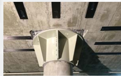
Stützenkopf rund, noch unverkleidet
