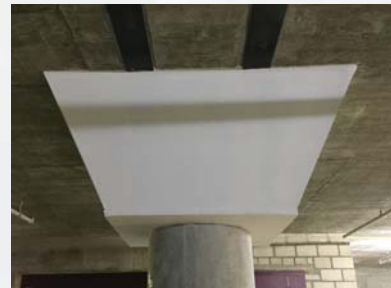
Stützenkopf rund, verkleidet
