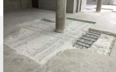
Aussparung um eine Stütze
