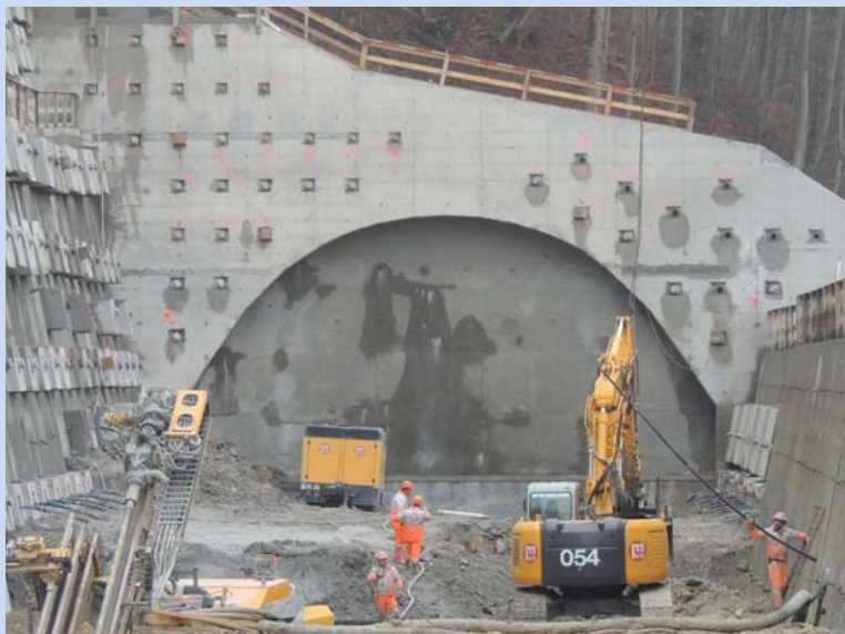
Tunnelportal Wösch nau
