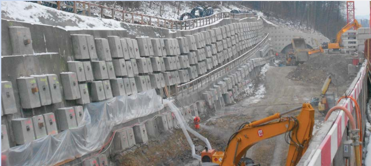
Blick in die Baugrube
