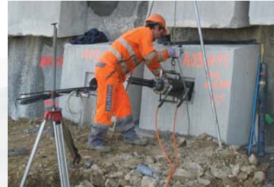
Prüfen und Festsetzen eines Ankers
