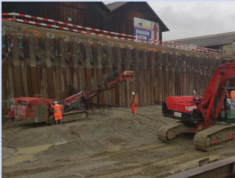
Phase de construction
