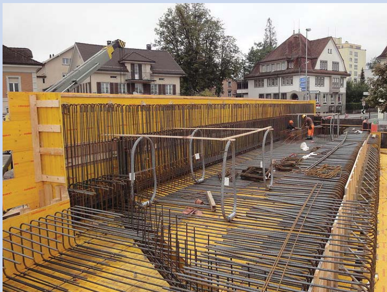
Montage Stahlseile
