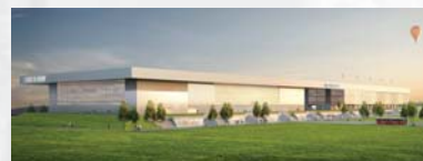
État à la fin des travaux
