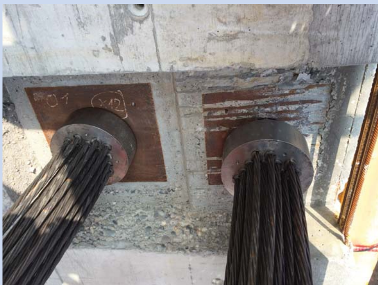
Faisceaux de torons avec têtes d'ancrage sans tension
