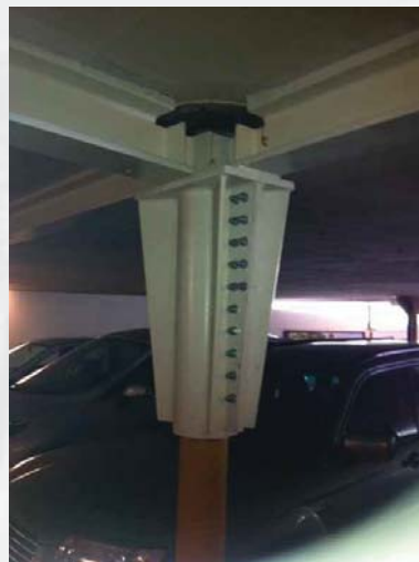
Stützenkopf StüKo als Auflager
