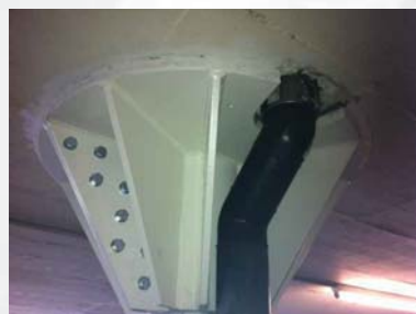
Stützenkopf StüKo rund mit Aussparung
