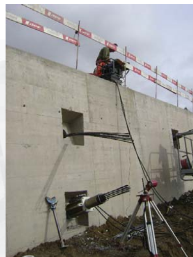
Travaux de mise en tension
