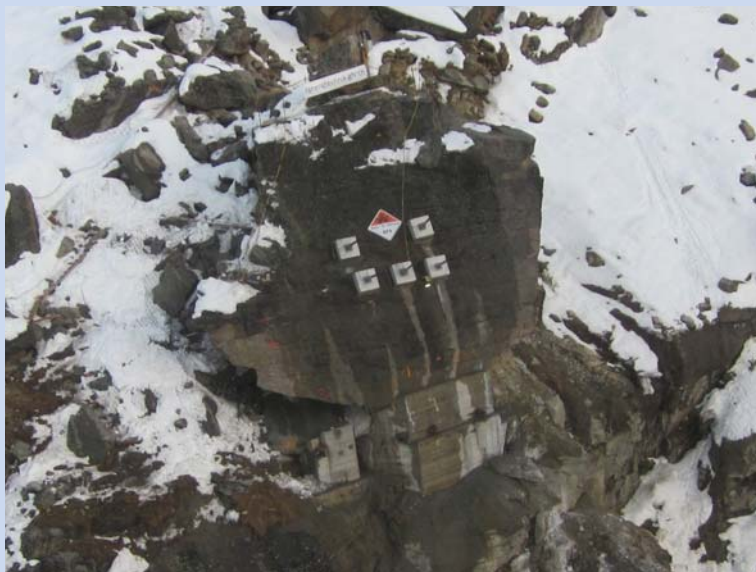
Etat à la fin des travaux
