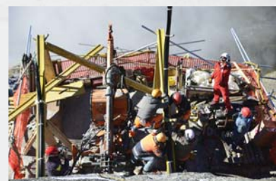
Mise en place d'un ancrage
