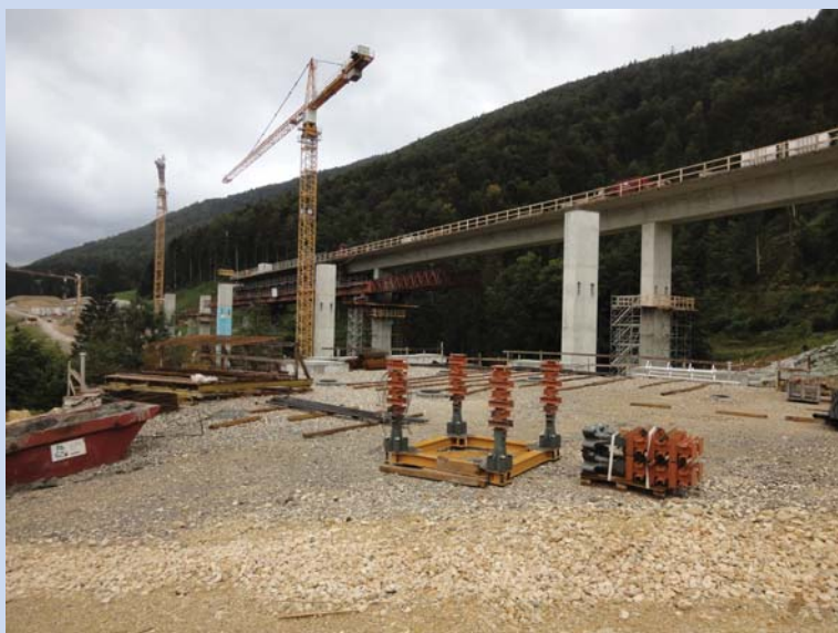
Déplacement des coffrages
