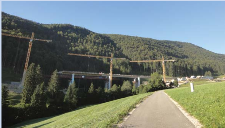
Obere Brücke während der Bauphase
