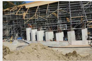
Stützen für Ringbalken
