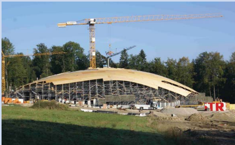
Halle mit Holzdachkonstruktion
