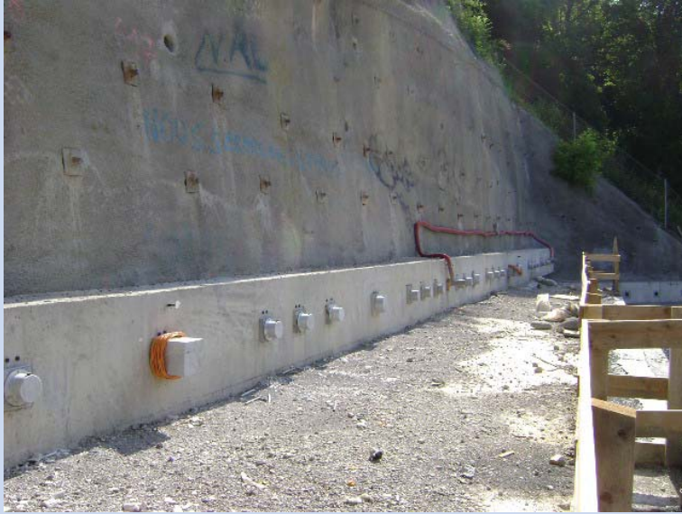
Sicherung der Felswand
