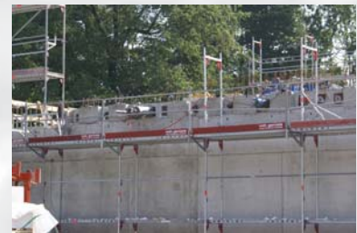
Decke über Kommissionierung - vorgespannt, um die Traglast zu erhöhen.
