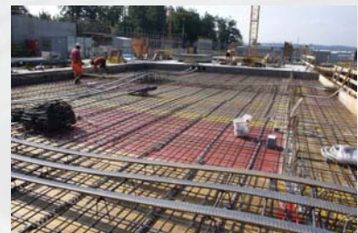
Quer- und Längsvorspannung mit BBRV A1000 und A1900 flach
