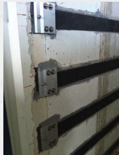
Stahllamellen mit Verankerungsplatten
