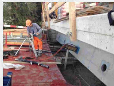
Versuchsanker prüfen
