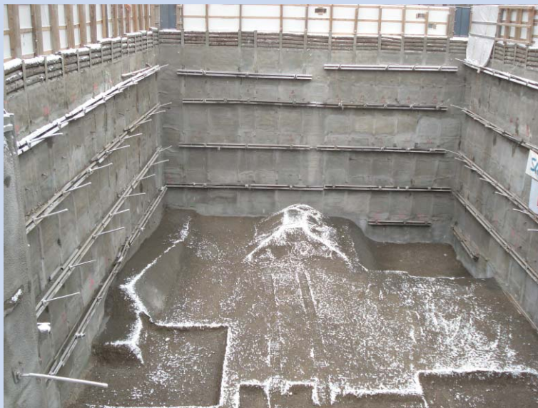
Baugrube mit temporären Ankern
